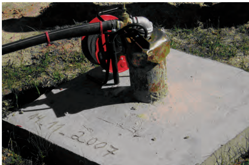
Fig. 28. Losa sanitaria. Terminación en superficie
