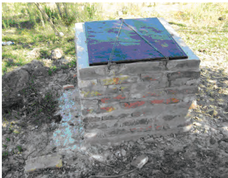
Fig. 29. Casilla de protección de pozo
