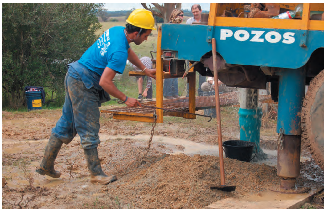
Fig.22. Perforador durante la construcción de un pozo.
