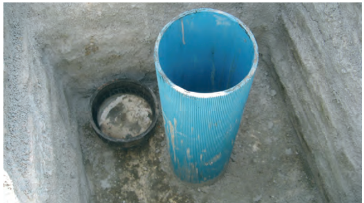
Fig. 23. Tubería sanitaria no apropiada para revestimiento de pozo
