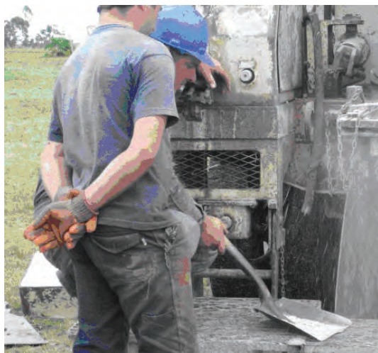
Fig. 33. Toma de muestras de roca programada en función del avance
