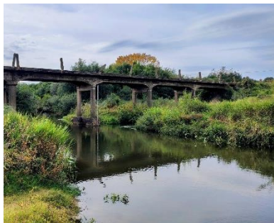
Figura 1. Vista aguas abajo.
