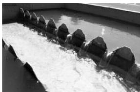
El agua ingresa a través de un conducto longitudinal, ubicado en el sector inferior de la unidad, y luego asciende a través de las placas, que es donde efectivamente sedimentan las partículas. El barro escurre hacia el fondo, y el agua clarificada se recoge en la superficie mediante canaletas con vertederos laterales.
