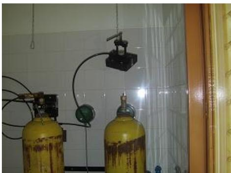
**7.6** Retire el envase vacío hacia el depósito y coloque el tapón de bronce protector de la válvula ajustándolo con la llave correspondiente (no a mano) (el tapón debe
