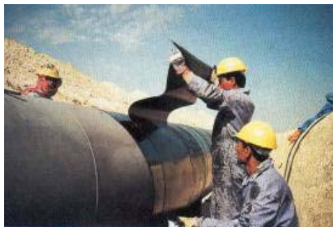
Fig. 59 Aplicación de cinta autoadhesiva.
