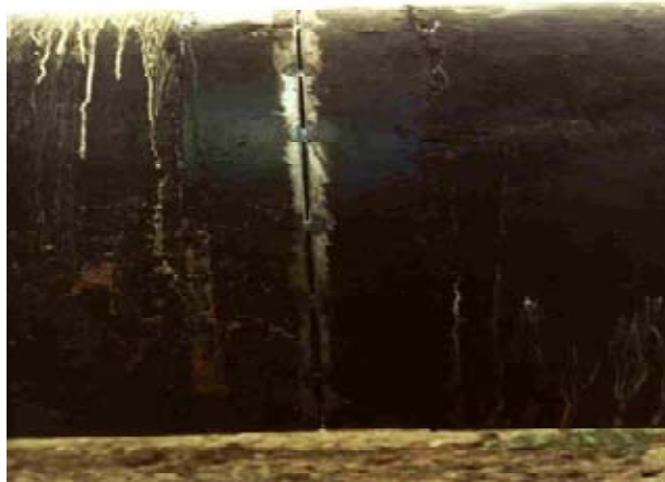
Fig. 62 Punteado de tubería
