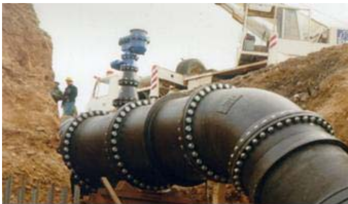
Fig. 29 Junta de bridas.
