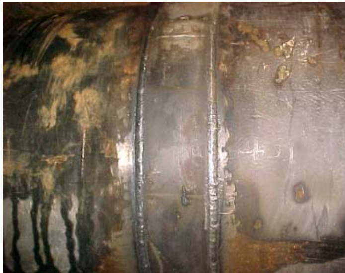
Fig. 80 Uniones soldadas mediante virolas.
