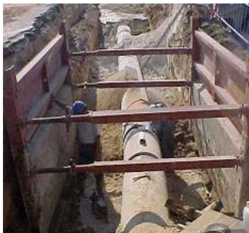
Fig. 9 Entibación en zanja para reparación
