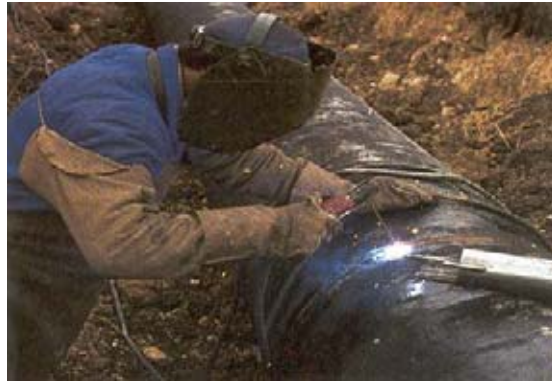
Fig. 79 Soldadura exterior.
