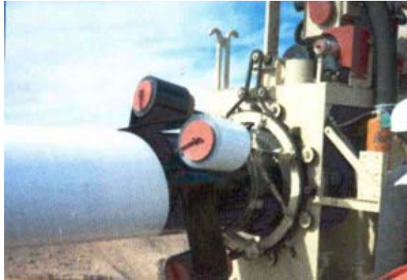
Fig. 83 Aplicación de cintas de polietileno por procedimientos mecánicos
