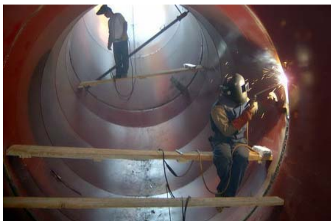
Fig. 81 Soldadura interior.
