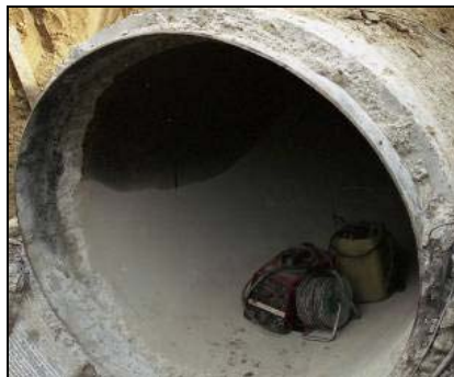
Fig. 8 No hay que dejar elementos dentro de un tubo
