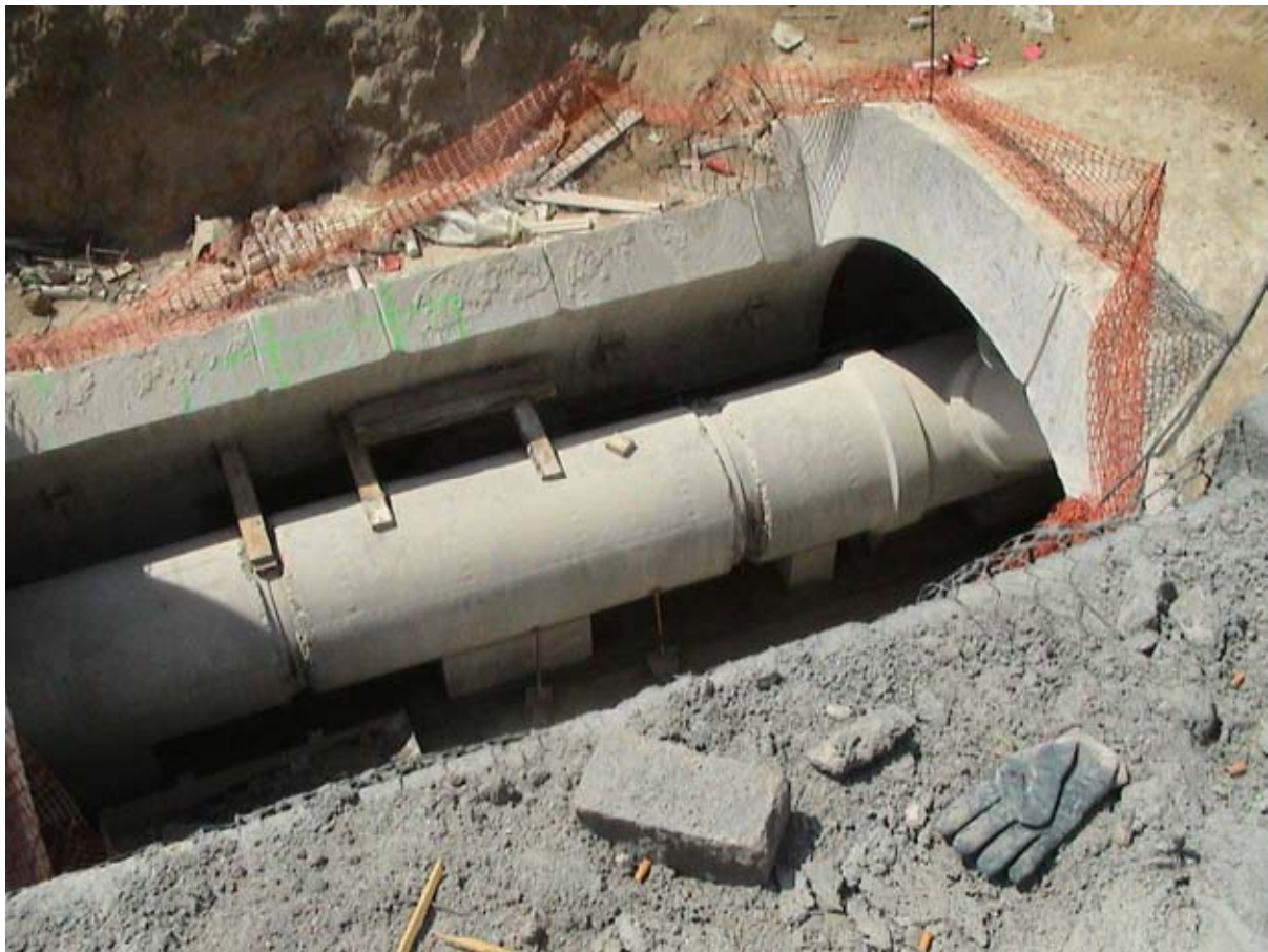
Fig. 50 Demolición de juntas exteriores
