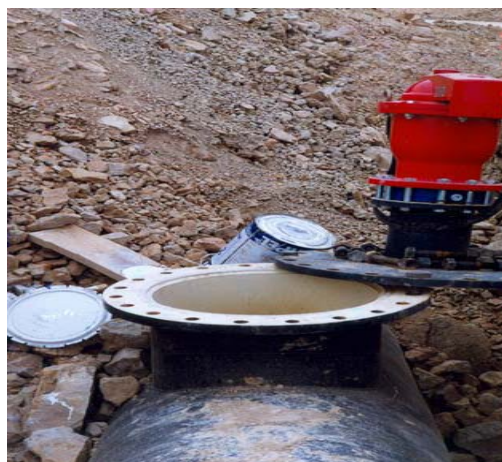
Fig. 71 Unión mediante bridas.
