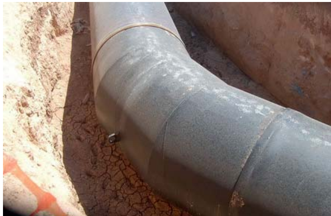
Fig. 78 Pieza especial: Codo soldado.
