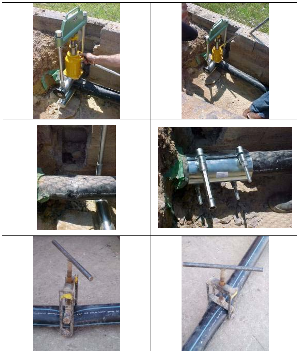
Fig. 97 Pinzamiento de un tubo
