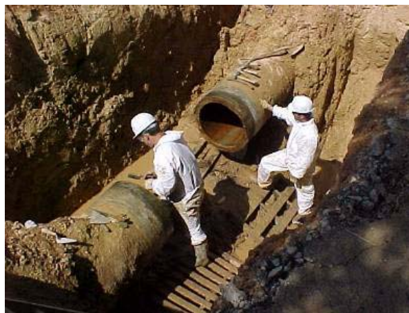
Fig. 16 Operarios reparando avería en tubería de fibrocemento
