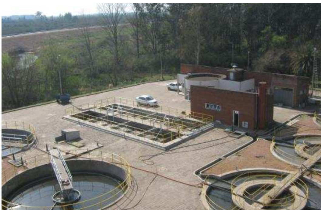
Figura 10: Vista general de la planta actual
