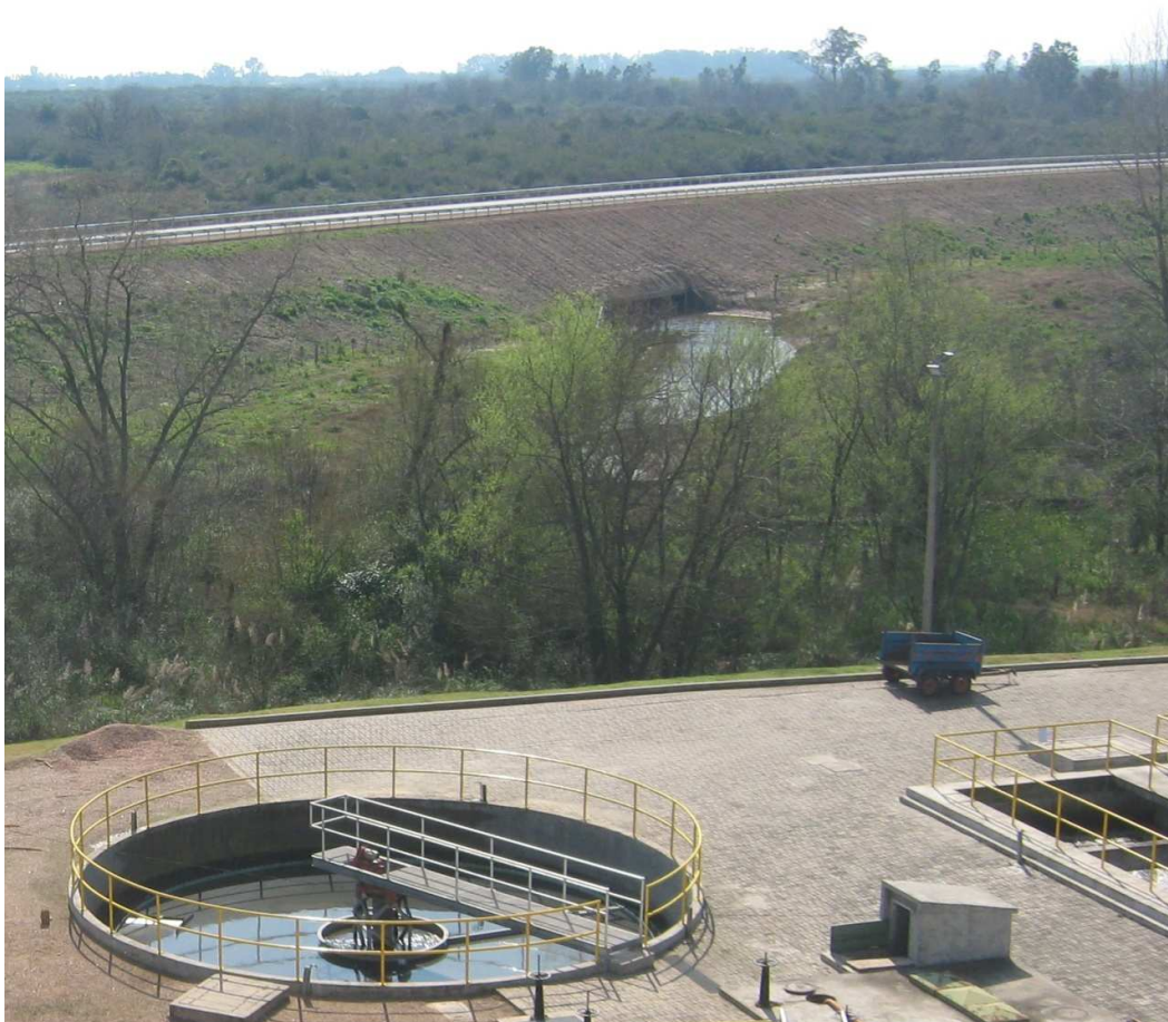
Figura 12: Terraplenado del nuevo tramo elevado de la Ruta 11
