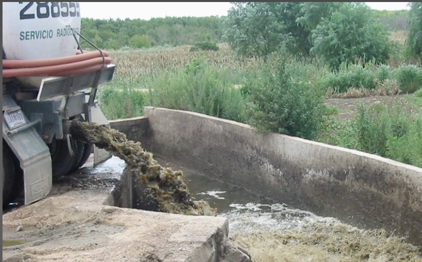
Vertido de los líquidos de barométricas en Planta Pinar Norte
