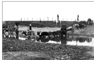
Transporte de caños para la instalación de la primera línea de bombeo. Planta de Aguas Corrientes, Canelones. Año 1868. (Archivo Histórico de OSE - Autor: s.d.).
